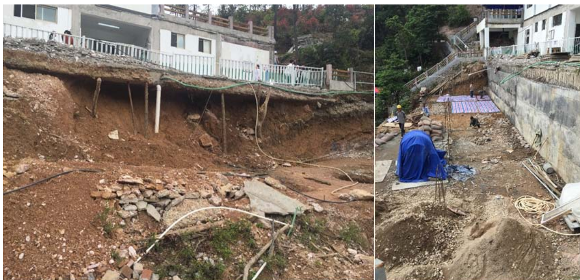
图 3-3 现神仙居索道上站平台沉降现场照片
