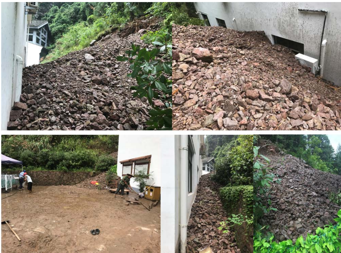
图 3-4 现神仙居索道下站泥石流现场照片
