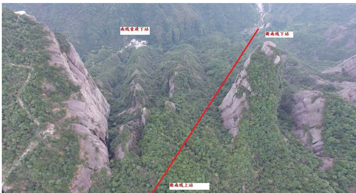
图 3-6 南线索道线路方案实景
